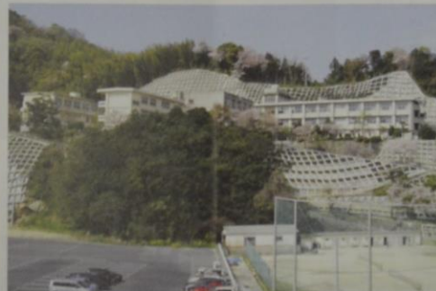
法面工事が進む周防大島高校
